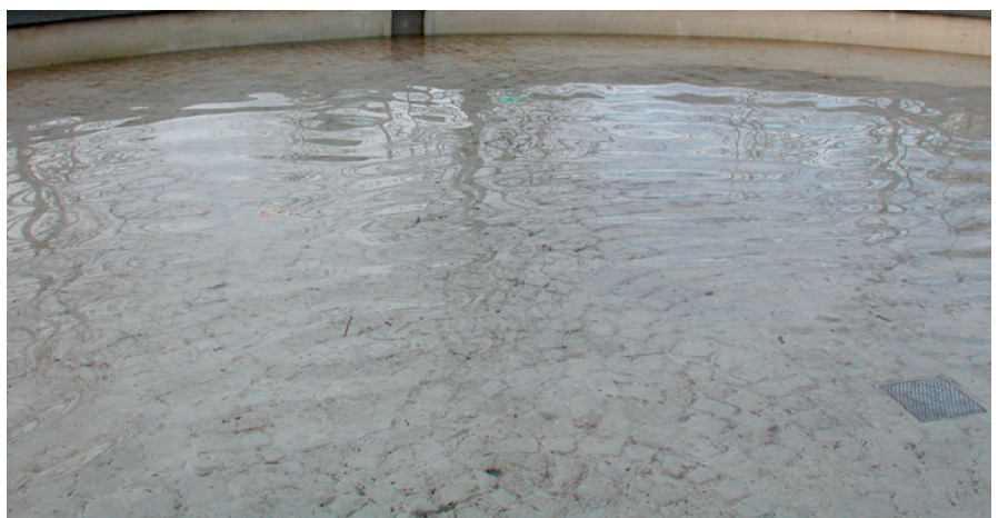
Verunreinigt durch 250 kg Kalk – der Rosa Luxemburg Brunnen vor der Reinigung.
