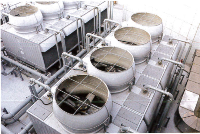
Das Biozid Biomeba als umweltfreundliche Lösung gegen Bakterien in Verdunstungskühlanlagen und Rückkühlwerken.
